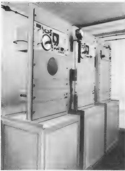
Bild 6. Die Quarzgeneratoren im Quarzkeller sind in schwingungsfreien Gestellen untergebracht. Temperatur- und Feuchtigkeitsfühler steuern die automatische Regelung von Raumtemperatur und Luftfeuchtigkeit
